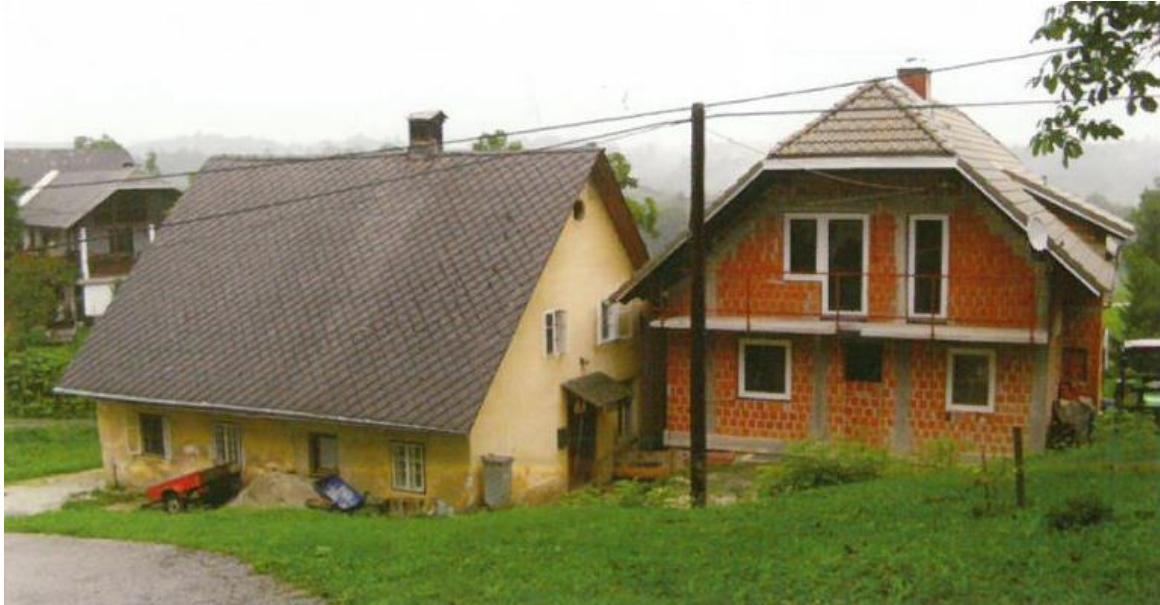
Mišače št. 7: Demšar in Toporiš (Kadunc), stara in nova hiša, 2008 Vir: Mišače in Rodbina Pegam (avtor Rok Gašperšič)
